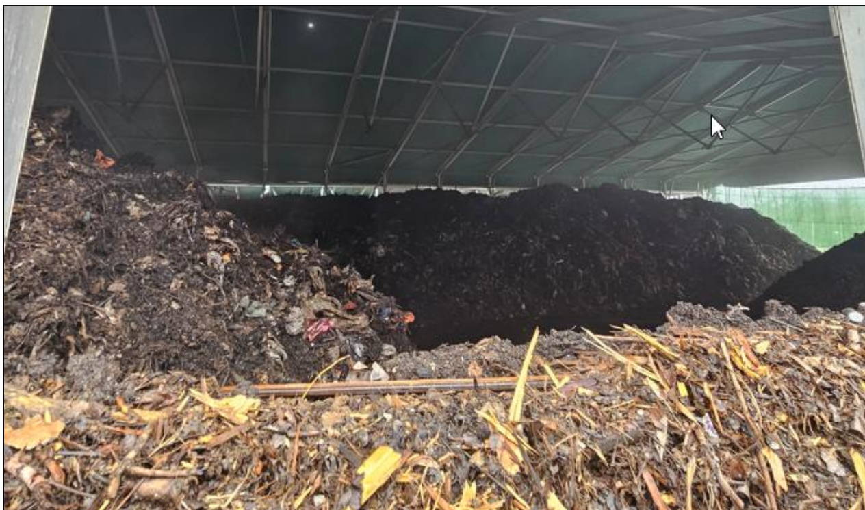
Slika 6: Pokrita nadstrešnica za skladiščenje lesnih odpadkov (spredaj) in komposta (zadaj)
